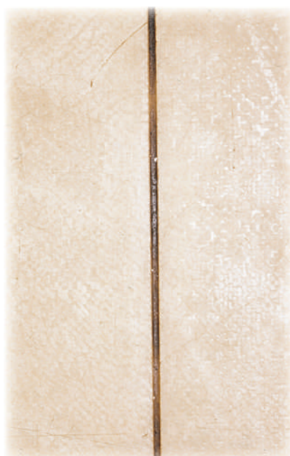
Fig.7b. Le joint siliconé (non soudé) est détérioré après les lavages réguliers avec les produits nettoyants-désinfectants
